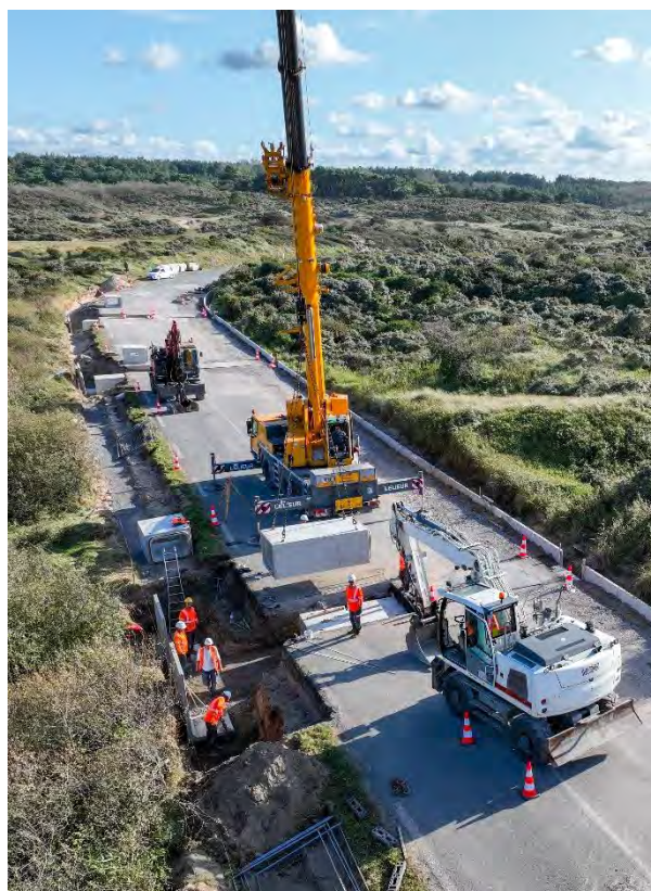
Réalisation du second tronçon de la Vélomaritime entre Wimereux et Ambleteuse, octobre 2023
